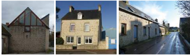
Nouveau percement qui s'intègre très bien au bâti ancien
