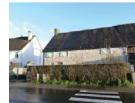
Peu d'ouvertures au nord - Maison à Chef du Pont
