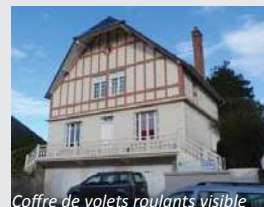
Coffre de volets roulants visible
