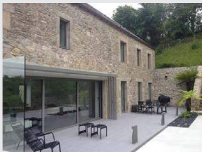
Réhabilitation intérieur/extérieur - Omonville
