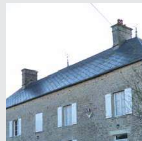
Girouette, cheminée et épi de toiture à Cretteville
