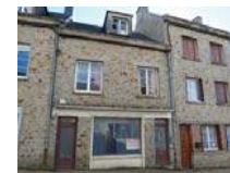
L'architecture de la Reconstruction, déclinaison moderne de la maison de bourg
