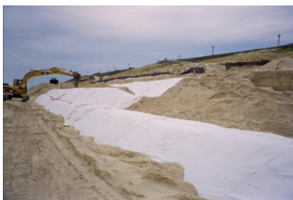
Fig. 14. Mise en œuvre de Stablenko® à Biscarosse (source ARTELIA)
