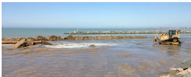
Fig. 13. Brise-lames et rechargement de plage de 80 000 m 3 à Châtelailon-Plage dans le cadre de la mise en œuvre du PAPI (ARTELIA 2013-2014 pour le compte du SILYCAF)
